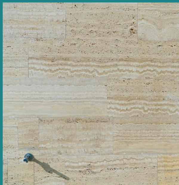
*Detailansicht: Die Travertinplatten sind knirschverlegt.*
