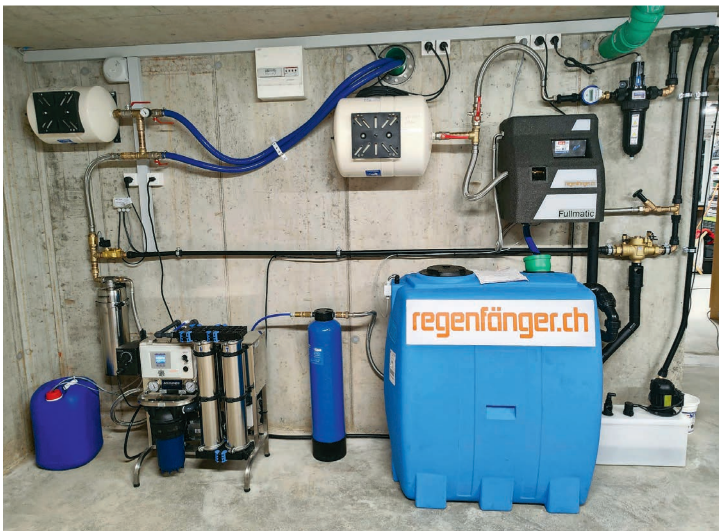
Une installation de traitement de l'eau Apro 150–750 qui transforme de l'eau de pluie en eau potable.
