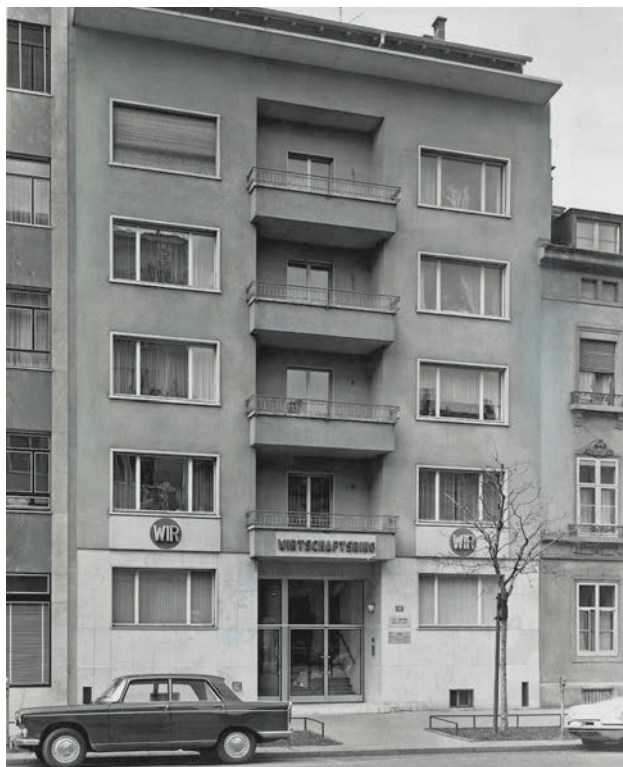
Le premier bâtiment dont le Cercle Économique fut propriétaire, au Steinengraben 12 à Bâle. Il hébergea le siège central de la coopérative depuis sa construction en 1955 jusqu'à la construction du nouveau bâtiment situé à l'Auberg 1, au milieu des années 1970.
