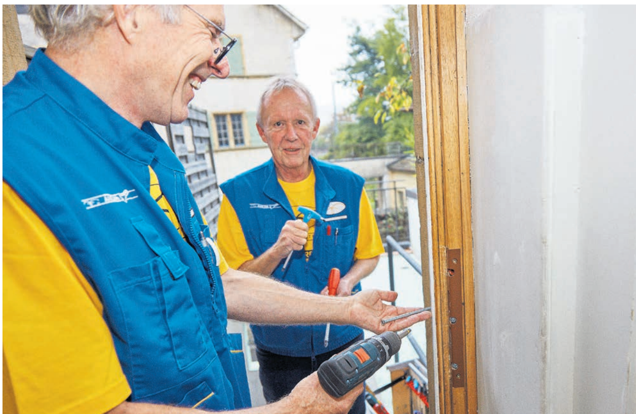
Ein robuster Beschlag ist das eine, das andere ist die feste Verankerung des Schliesspunkts im Mauerwerk: Hannes Eltrich mit Mitarbeiter Erich Gerber, einem pensionierten Polizisten.
