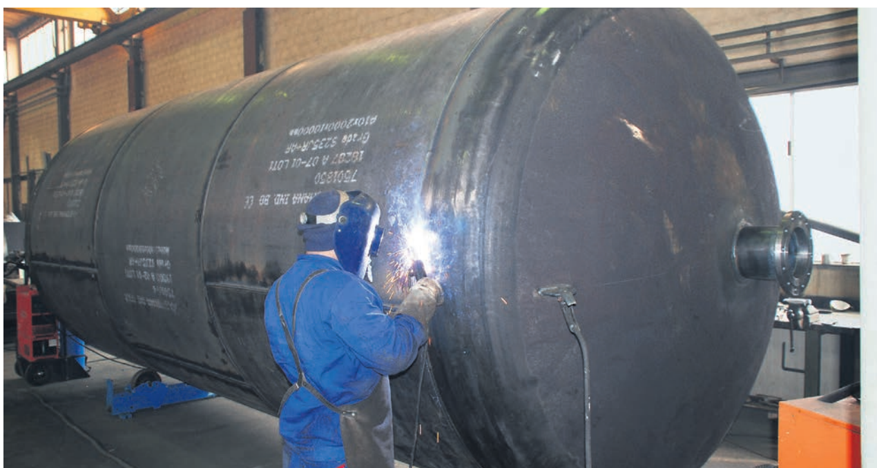
Viele Tanks sind so gross, dass sie erst auf der Baustelle zusammengeschweisst werden können.
