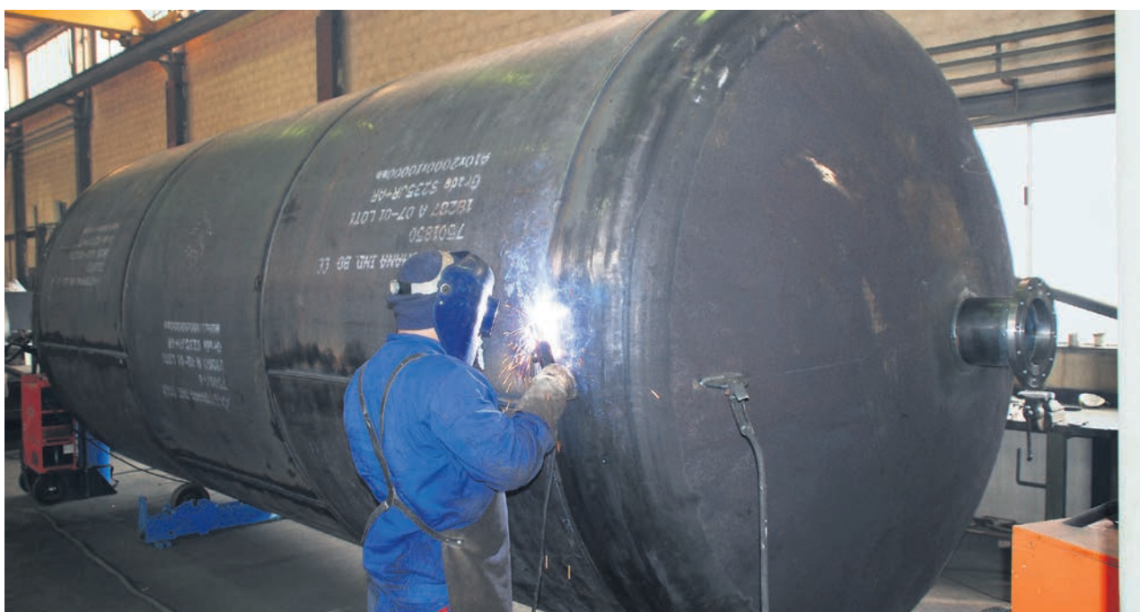
De nombreux réservoirs ont des dimensions si grandes qu'ils doivent être assemblés directement sur le chantier.
