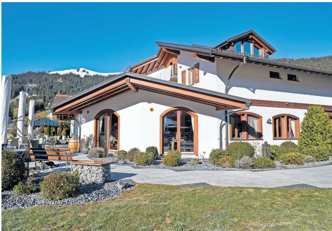
Der Baugrund für den «SchwarzseeStörn» wurde um einige Meter angehoben, um die Sicht auf den Schwarzsee zu optimieren.
